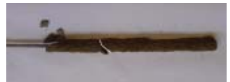
写真-2 グラウト部のクラック(引張型)
