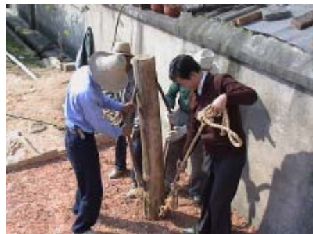
図-1 匯観山祭壇の復元工事
