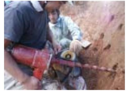
図 6 削孔状況
