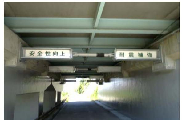
写真-1 ダンパー材の設置状況(4箇所)
