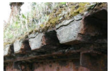
写真 2 床版損傷状況
