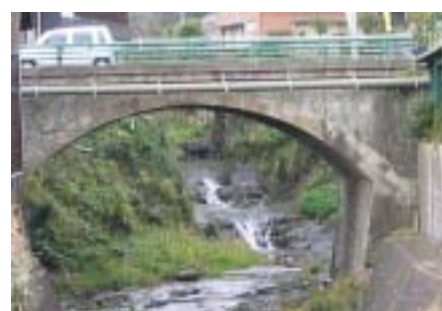
図-1 湯野田橋(佐賀県、国道 34 号線)
