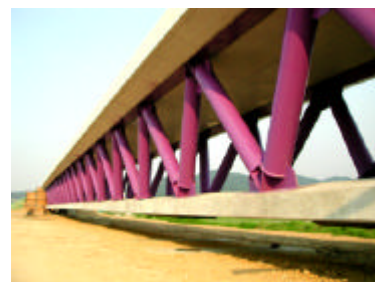
写真-1 PCT 桁
