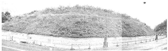
写真-3 施工後6ヶ月の斜面状況
