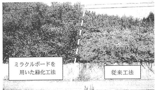
写真-1 従来工法との比較 (施工後4年6ヶ月)
