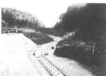
写真2 河川改修後(H14.1)
