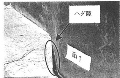
図-3 接合部のハダ隙現象
