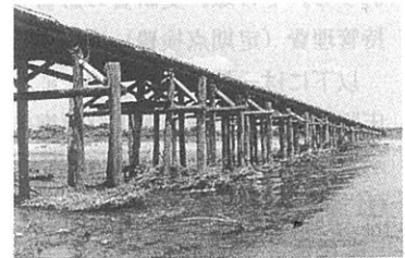
写真-1 上津屋橋全景
