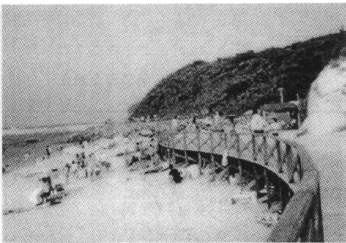
写真-1.ボードウォークと石張り護岸 (脇田)
