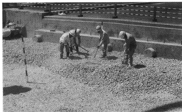
写真-2 発泡廃ガラス材の敷き均し状況
