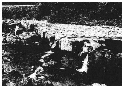
写真-1 改修前の滝の状況
