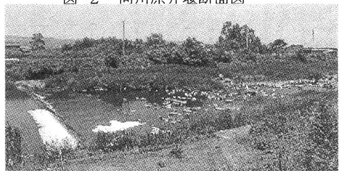
写真-1 向川原井堰下流の河道
