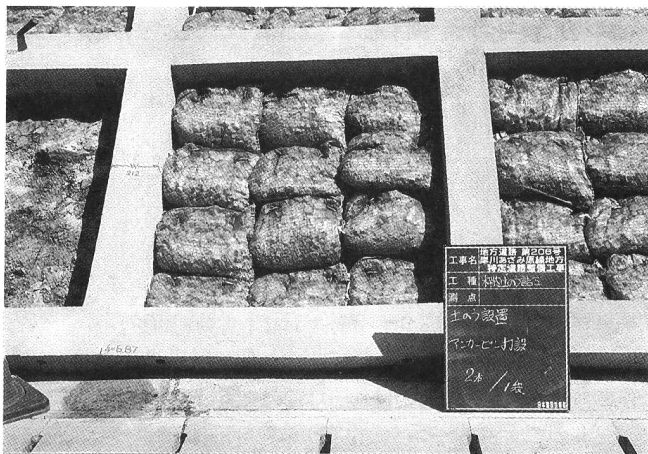
写真-1 法枠内の発泡廃ガラス材入り土嚢の設置状況
