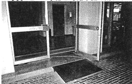
写真-3 工学部 1 号館エレベータ前玄関口
