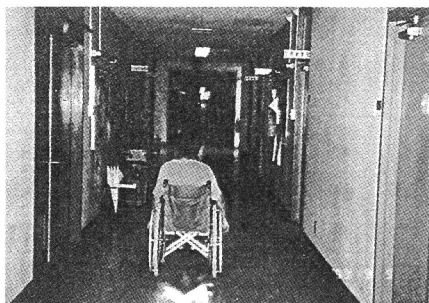
写真-1 工学部 1 号館内の通路
