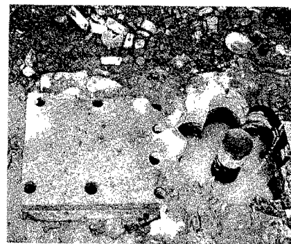
写真-2 門型フレーム設置場所整備後
