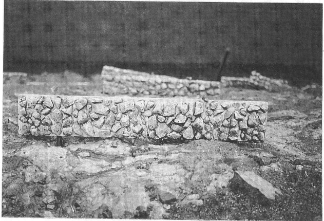
写真-2 発泡廃ガラスボードの設置状況
