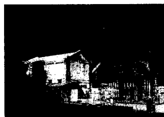
川走川第一発電所
