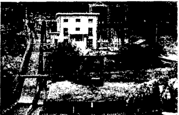
川辺川第一發電所
