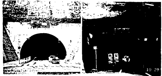
写真 1 西浦上トンネル
