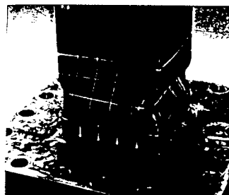
(写真 1) 柱基部の局部座屈
