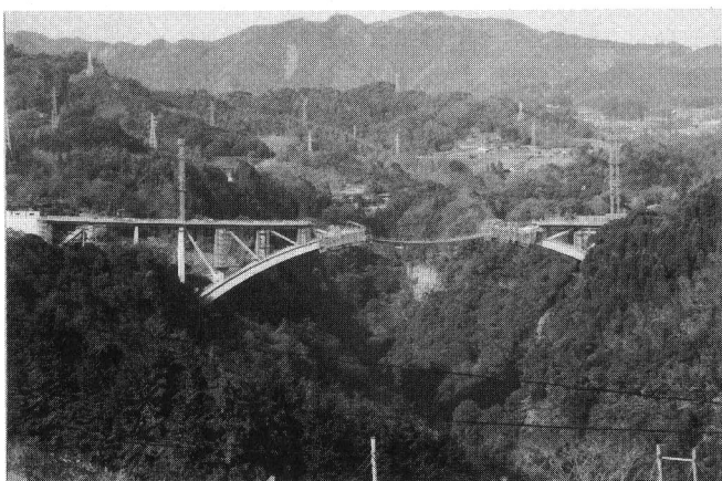
写真－2 平成7年11月施工状況
