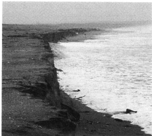
写真1. 浜崖に衝突している波の様子
