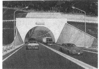
写真－7 日見第1トンネル
