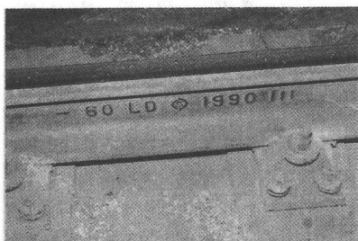
写真2 シクリチプライマー+カーボハイト塗装レール
