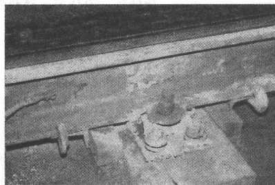
写真3 補修塗装部
