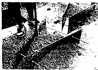
写真-2 設置後1ヶ月
