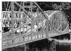
写真-1 南河内橋
