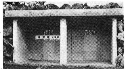
写真-1. 既設の避難壕の例
