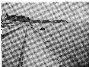
写真1 階段式護岸(No. 8付近)
