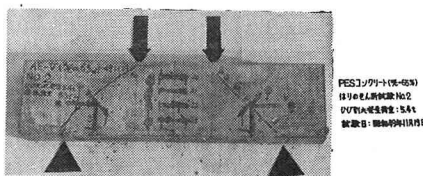
写真-1 セン断桁のひびわれ状況
