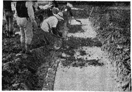
写真-1 敷ばうし法工事
