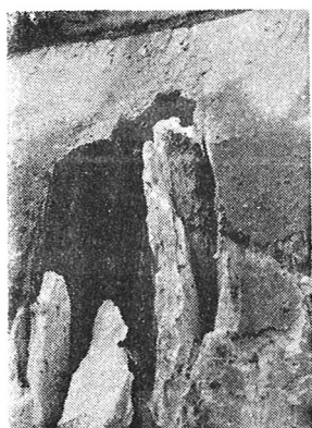
写真-8、切土斜面の次蝕例 (宮崎県高城町四家、国道10号線)
