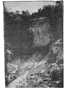
字奥-2. 根占町市川内の山腹崩壊
