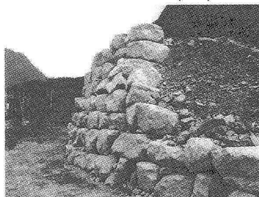
図-3 試験施工法面(側面)
