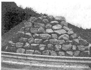
図-2 試験施工法面(全景)
