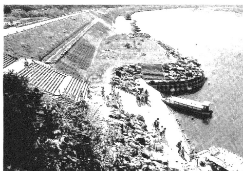
現況（下流側より）
