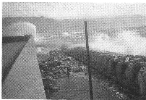
写真-2. 図-1のD断面の消波状況
