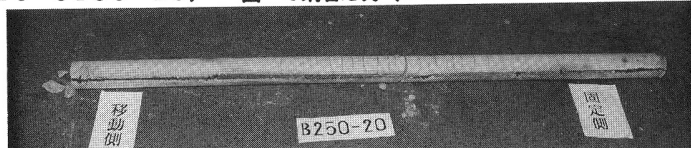
写真-2 崩壊モルタルクラック (B250-20)
