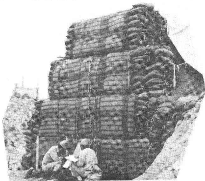
図-4 盛土の完成状態
