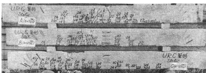
写真-6 異形丸鋼低鉄筋ばりの荷重様相 A,B,C の場合のひびわれ
