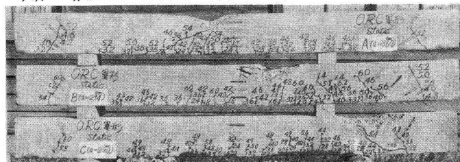
写真-7 異形丸鋼過鉄筋ばりの荷重様相 A,B,C の場合のひびわれ
