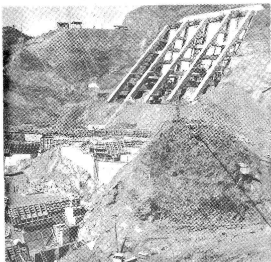
写真-1 バットレスによる左岸切取状況
