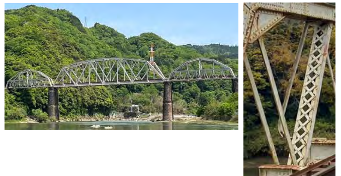
写真-1 対象橋梁の全体写真 写真-2 斜材拡大図
