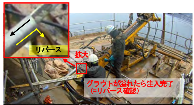
図6 タイムラプス映像によるグラウト注入完了確認
