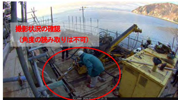
図5 タイムラプス映像による削孔角度確認
