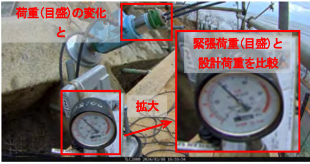
図-7 タイムラプス映像による載荷荷重確認
