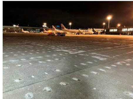
図-11 工事完了後の状況
