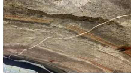
図-4 TDR センサ (長さ 9.95 m) 取付状況
