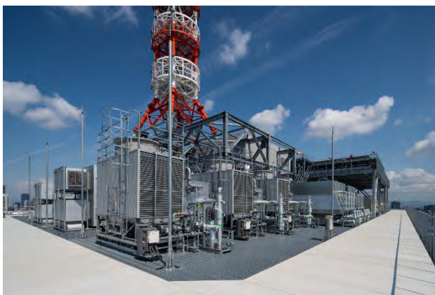
写真-2 塔屋1階設備機器置場
