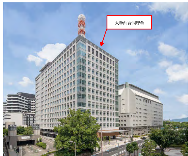
写真-1 大手前合同庁舎全景
