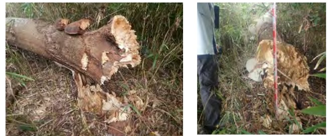
写真-3 地際部分
