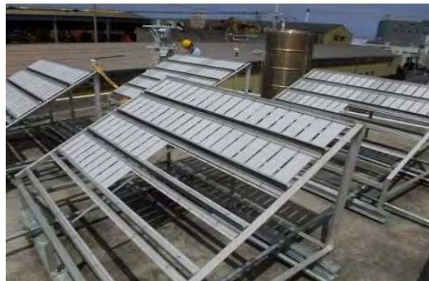
図 1 試験体の設置状況
