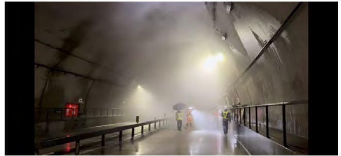
図-7 実噴霧点検の様子
