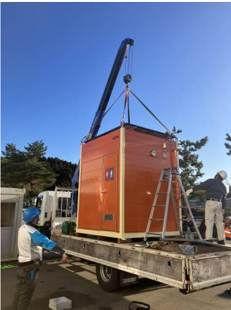
写真-3 循環式トイレの設置
