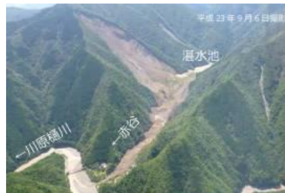
写真-1 赤谷地区 被害直後
