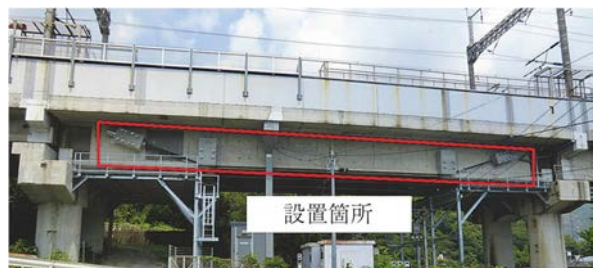
写真-1 外ケーブル張力モニタリング設置状況 1)
